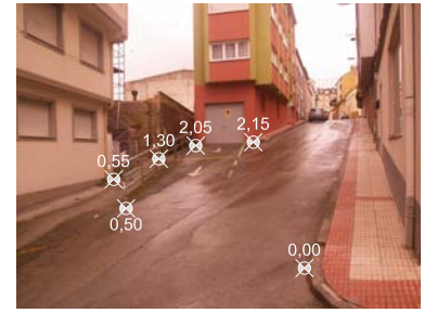
C/ VISTA ALEGRE Y LATERALMENTE VIARIO RODADO SIN SALIDA DESNIVELES Y BARANDILLAS DE PROTECCIÓN
