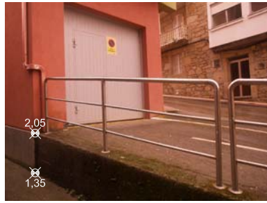
DESNIVEL ENTRE C/ VISTA ALEGRE y VIARIO RODADO SIN SALIDA
