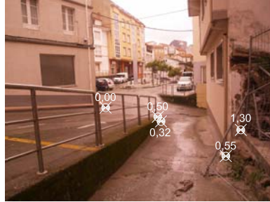
DESNIVEL ENTRE VIARIOS y BARANDILLAS DE PROTECCIÓN
